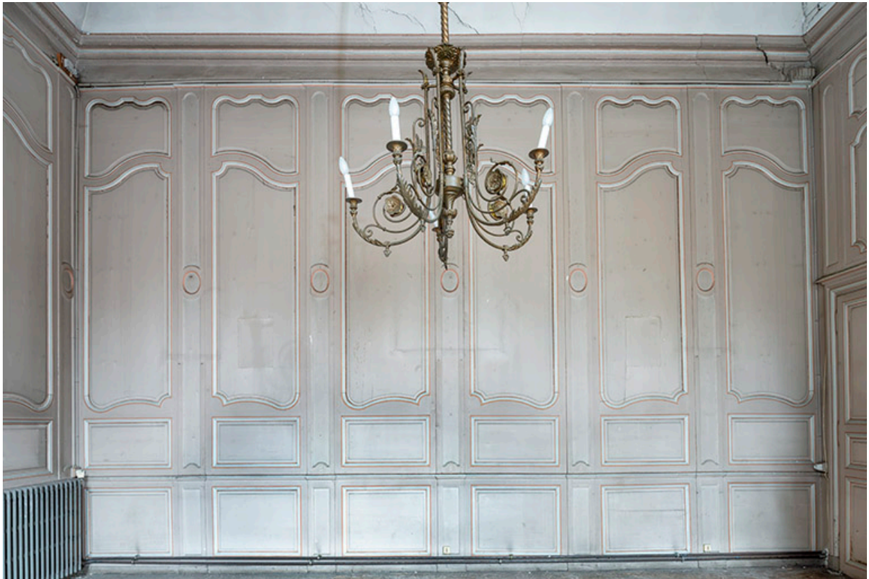
Aile nord. Lambris de la pièce au premier étage.
