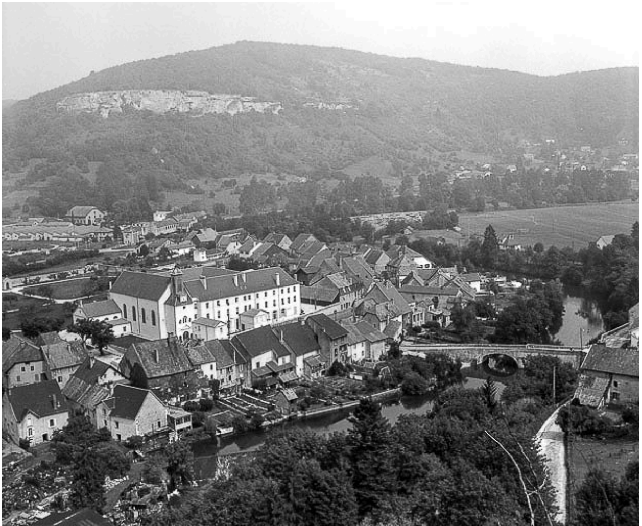
Vue générale depuis le sud-ouest.
