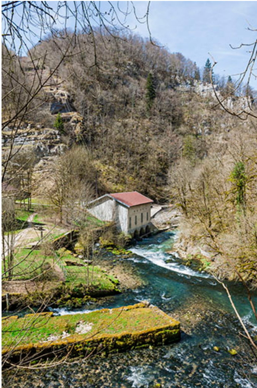
Vue plongeante sur la centrale.
