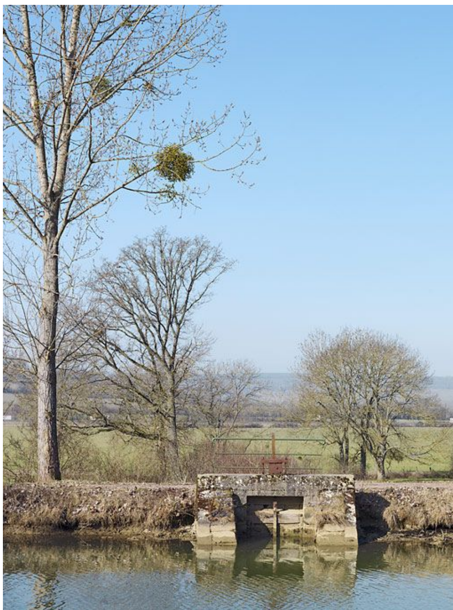
Le déversoir rive gauche de face.
