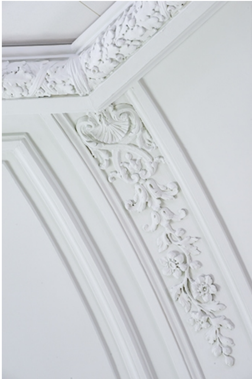
Salle de repos (ancienne salle d'attente), nervure du couvrement.
