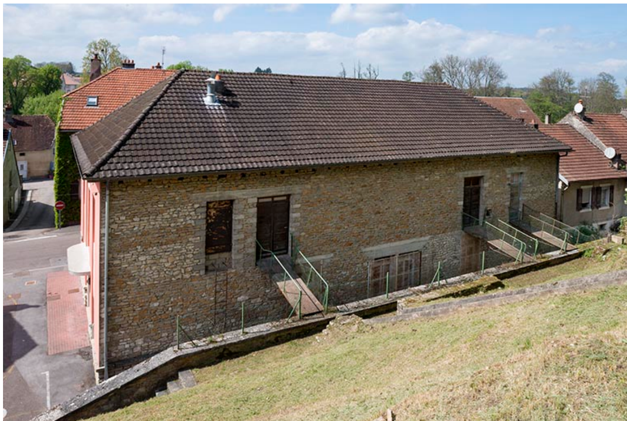
La façade postérieure.
