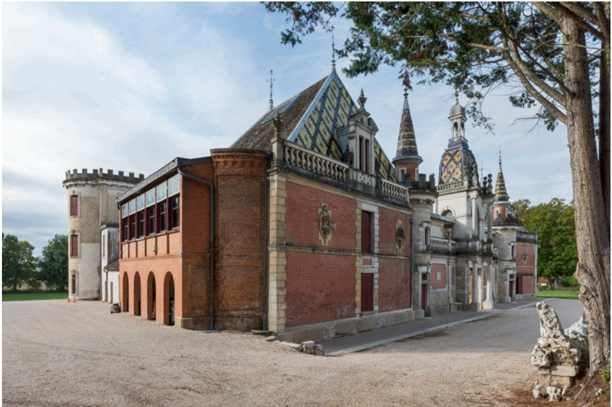
Elévations postérieure et latérale gauche.
