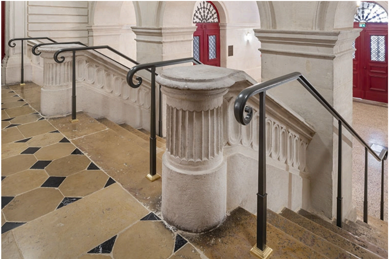
Vestibule, palier de l'escalier : départs de rampe.
