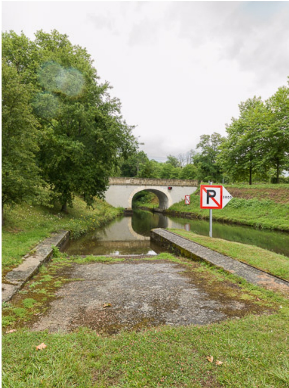
Vue d'ensemble du pont.
