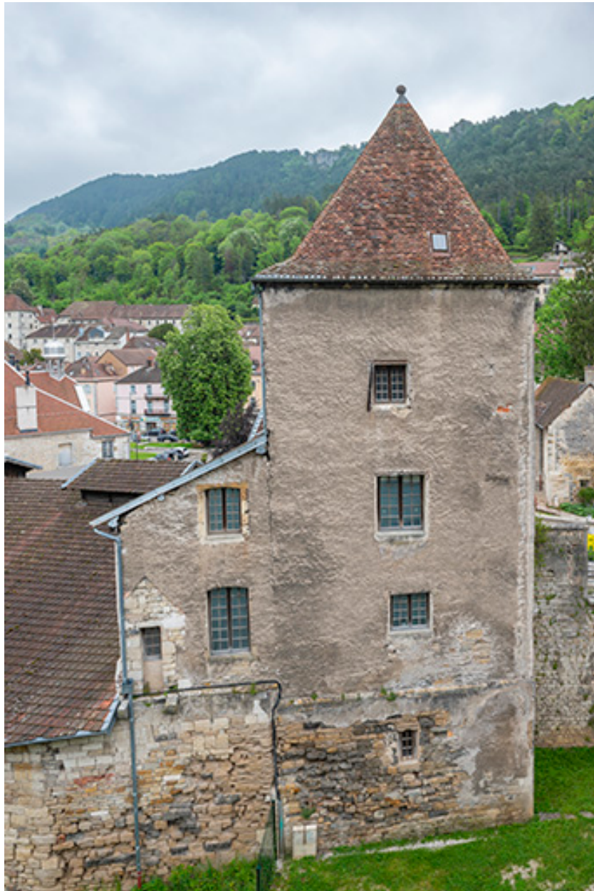
Elévation ouest de la tour de Reculot.
