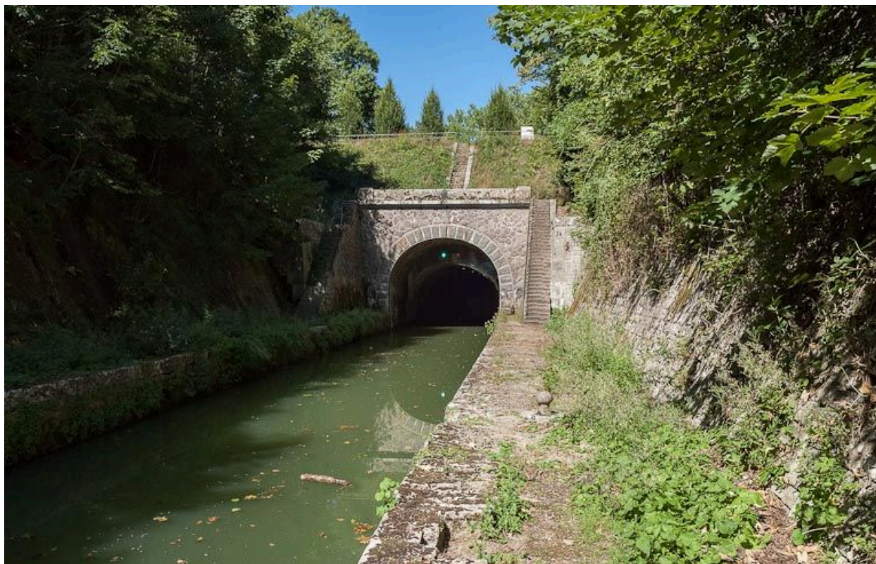
Vue de l'entrée du tunnel à Créancey.
