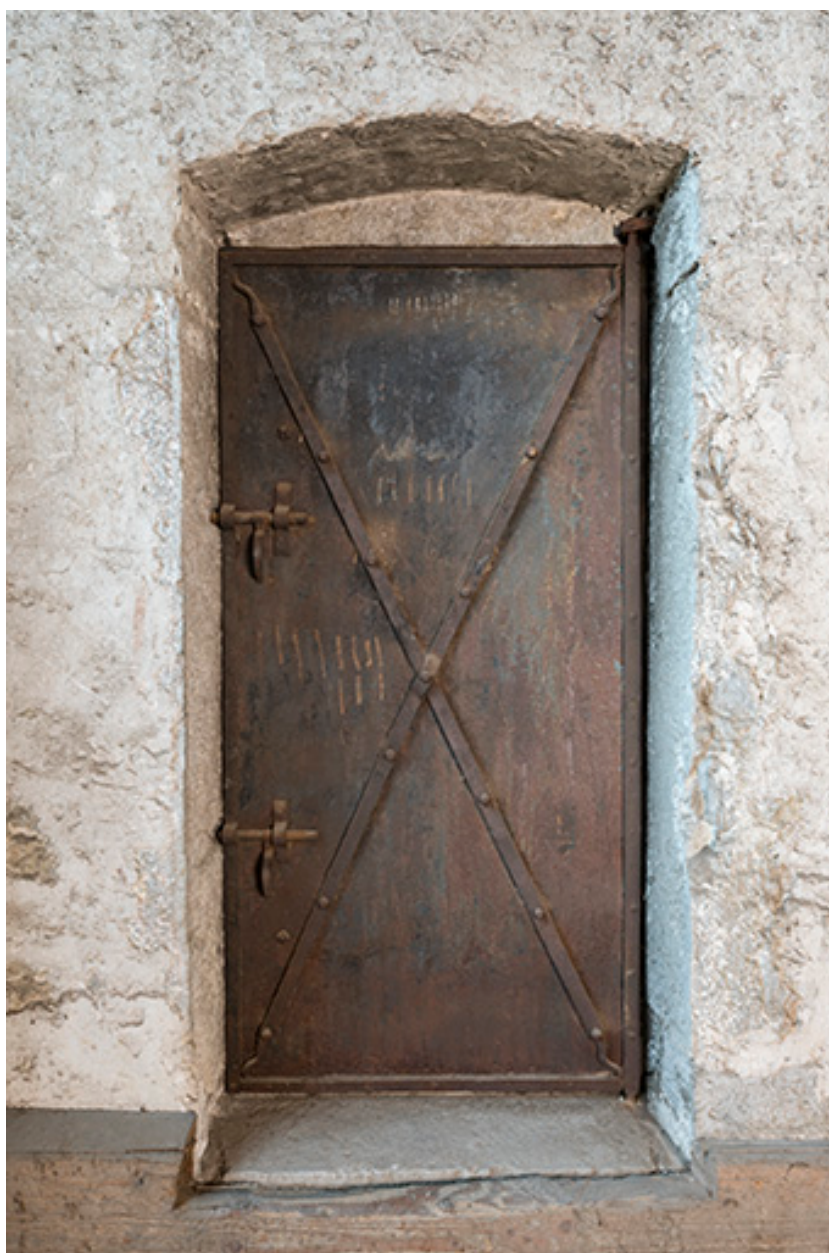
Intérieur, grange : porte métallique de la pièce à l'étage du corps sud-est.
