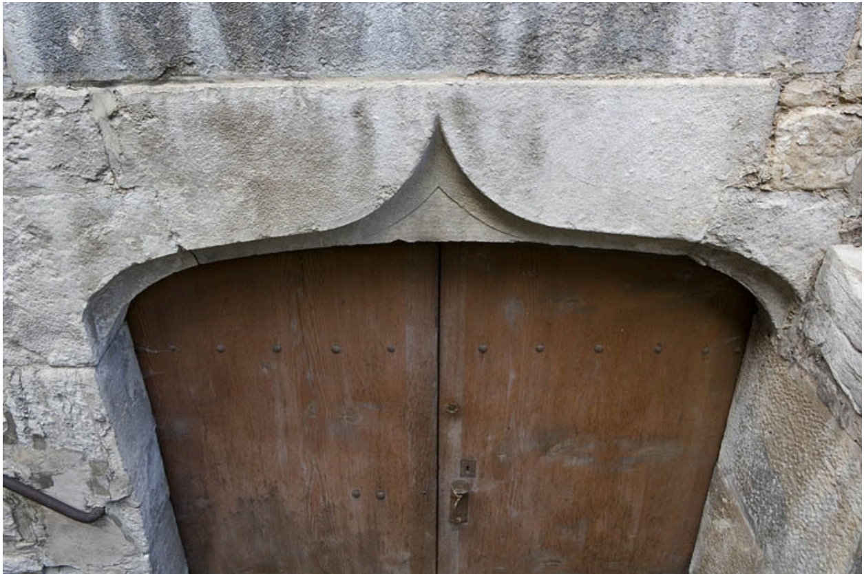
Détail de l'entrée du sous-sol sur cour.
