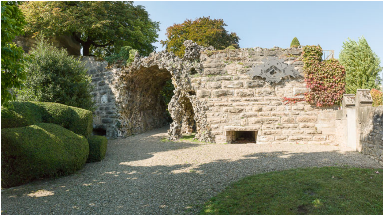
Passage aménagé dans l'ancienne courtine.
