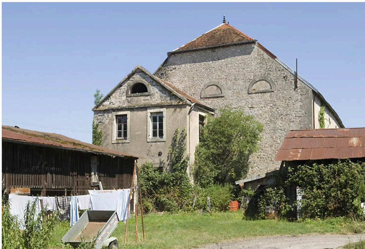
Le haut fourneau vu depuis le sud.
