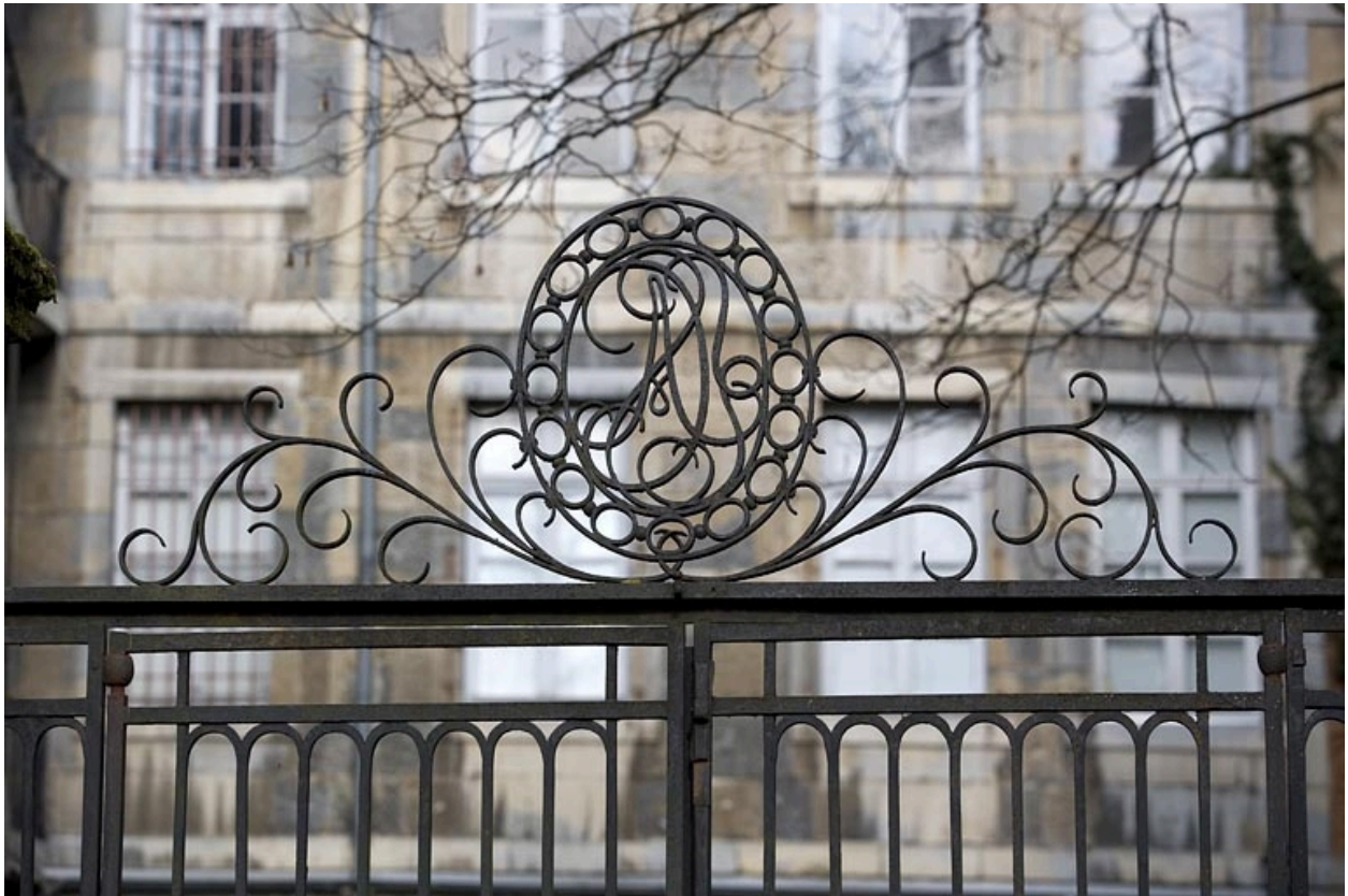
Détail du couronnement de la grille du jardin.
