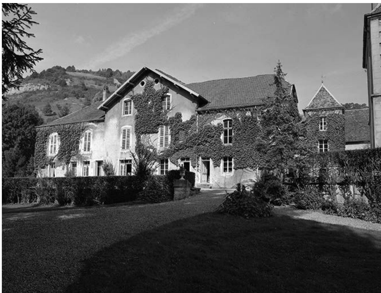
Façade antérieure du logement du gardien.
