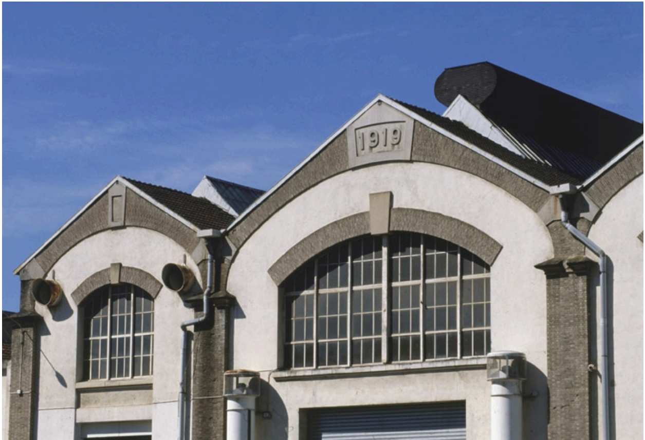
Détail des pignons de l'ancien atelier de soudure et d'assemblage.
