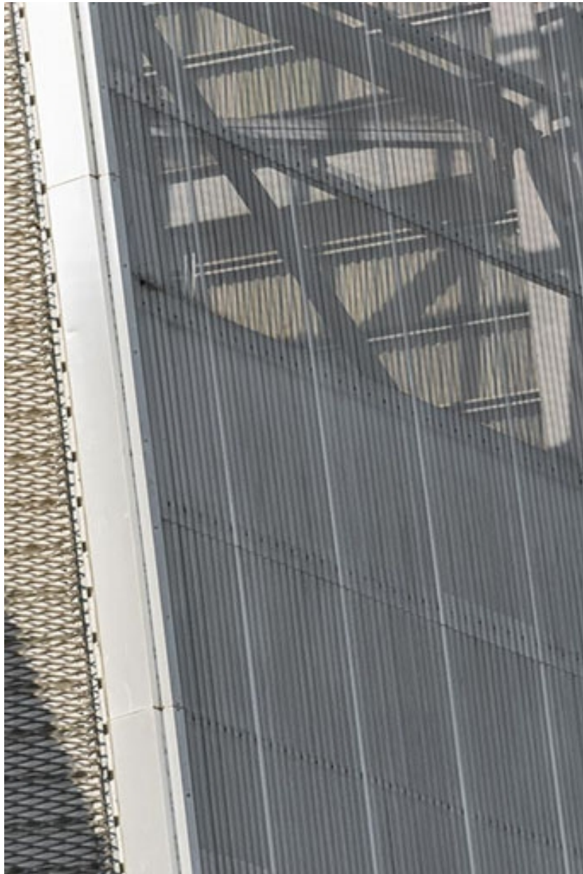
Bardage de la façade-écran.
