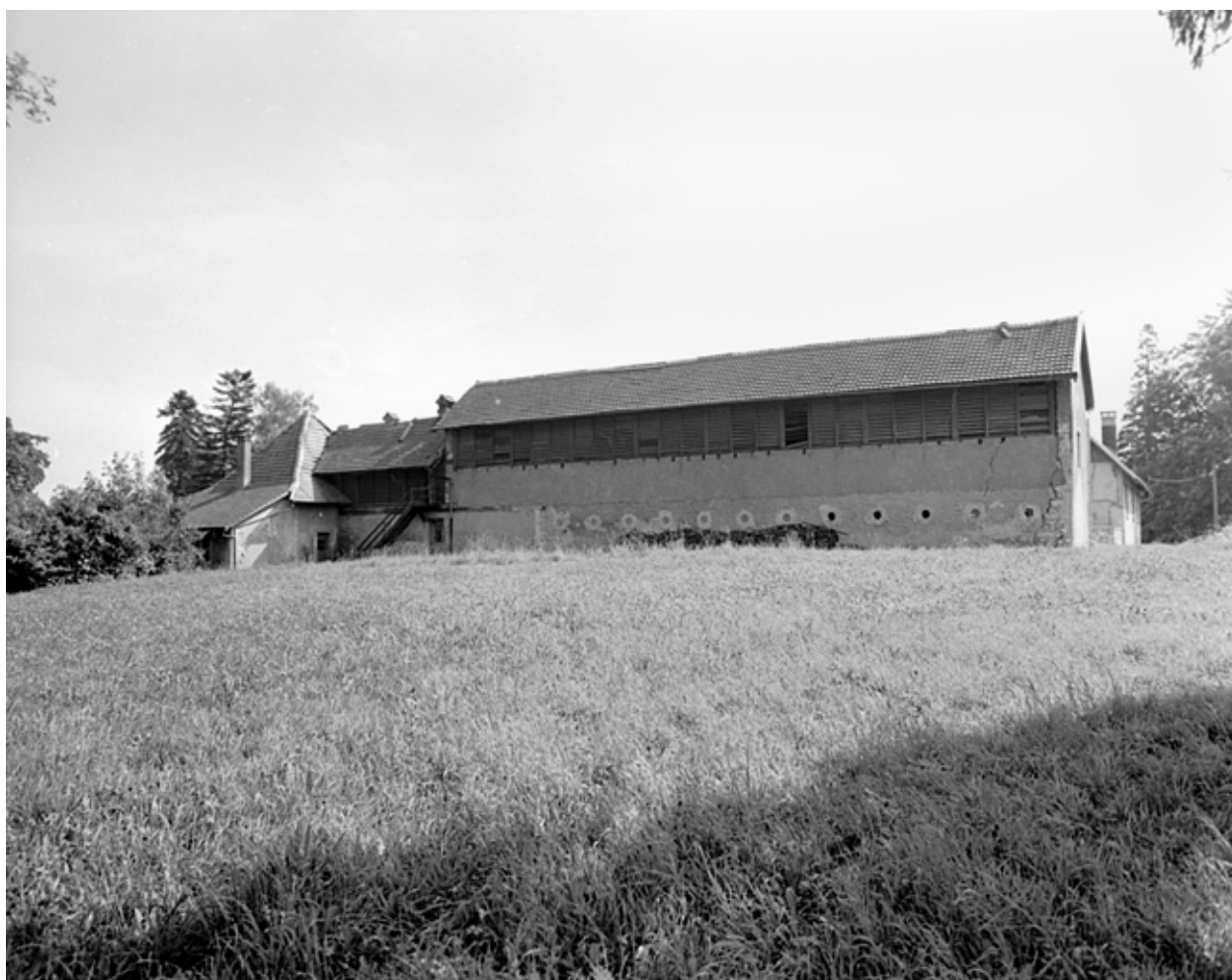
Façade nord de l'orangerie en 1981.SRI. Enquête régionale sur les bâtiments industriels (1979-1981).
