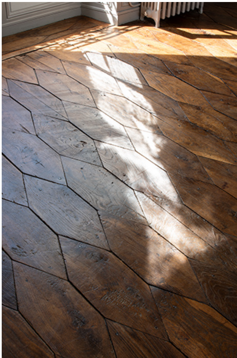
La première chambre de l'étage, côté nord. Détail du parquet.
