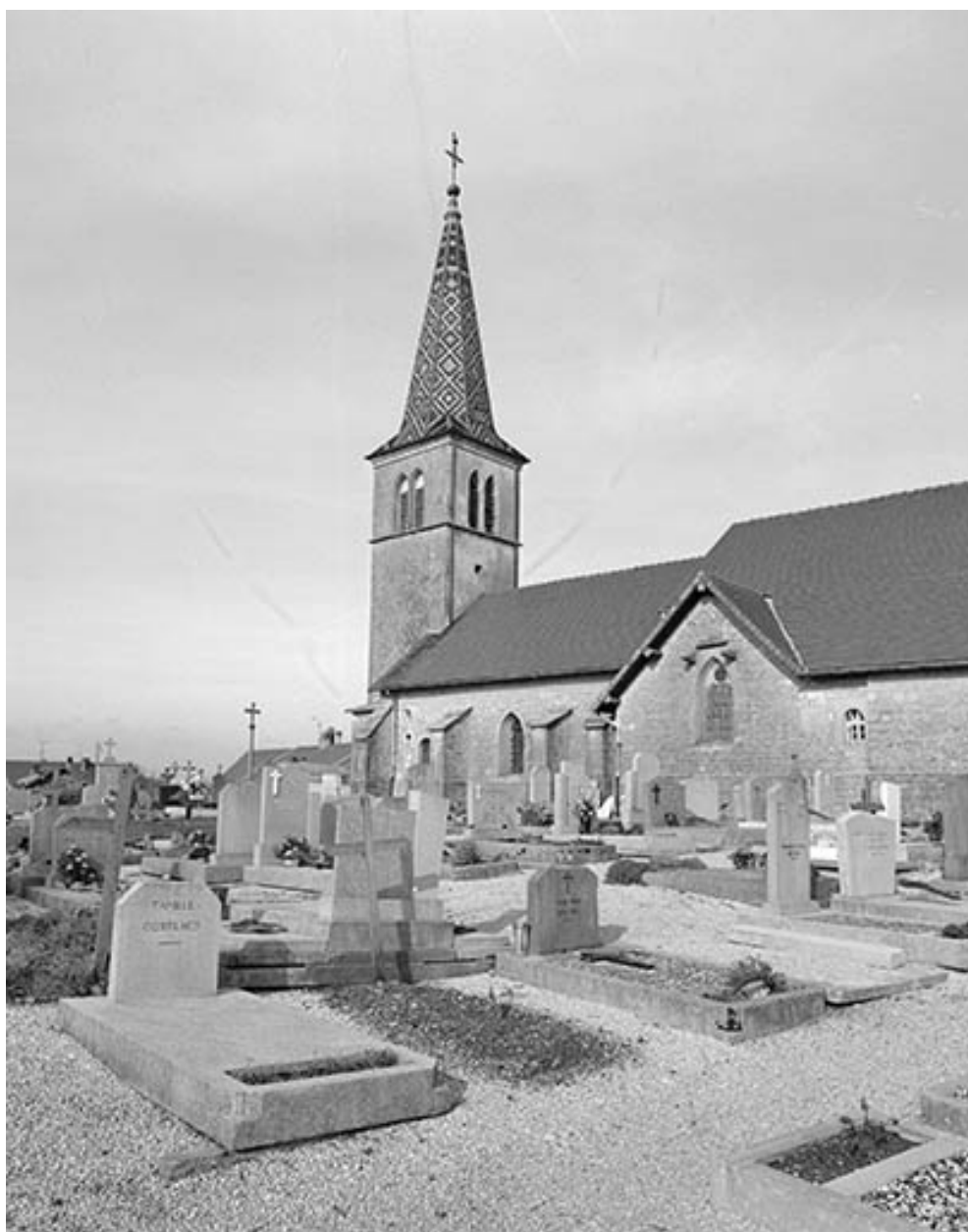
Extérieur : face latérale droite, partie gauche.
