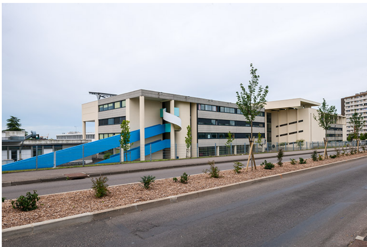
Externat : façade postérieure.
