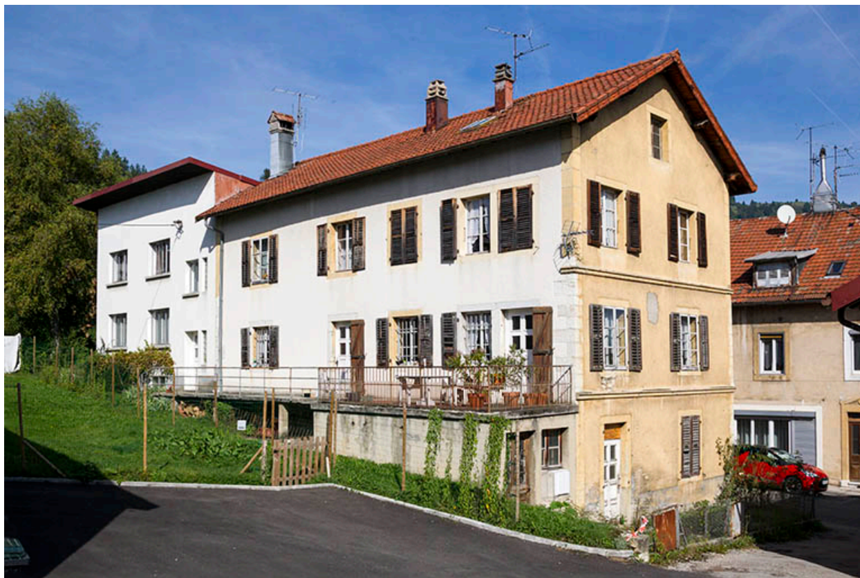
Façades postérieure et latérale gauche.
