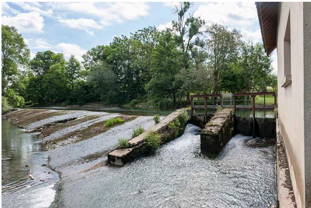
La barrage depuis l'aval et le vannage de décharge.
