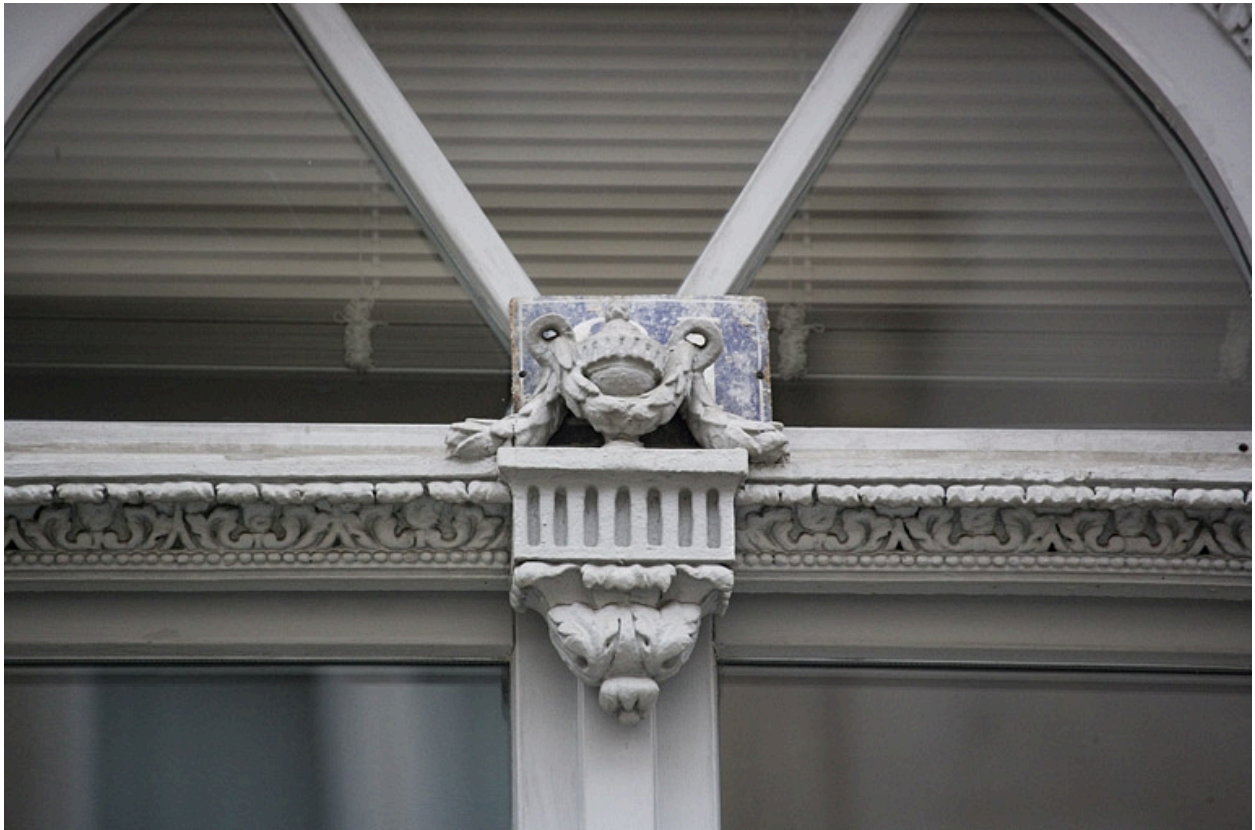
Détail de l'urne décorant la traverse dormante de la porte-fenêtre donnant sur le balcon.
