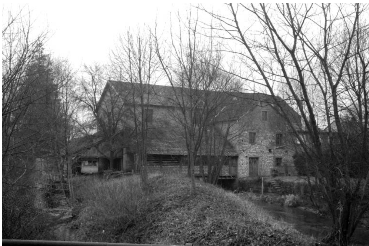
Façade postérieure de la minoterie.
