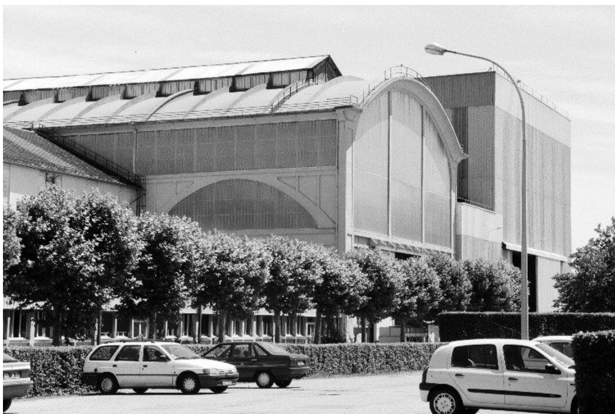
La halle de montage de 1919 et l'ATelier Lourd de 1973-1974, pignons ouest.
