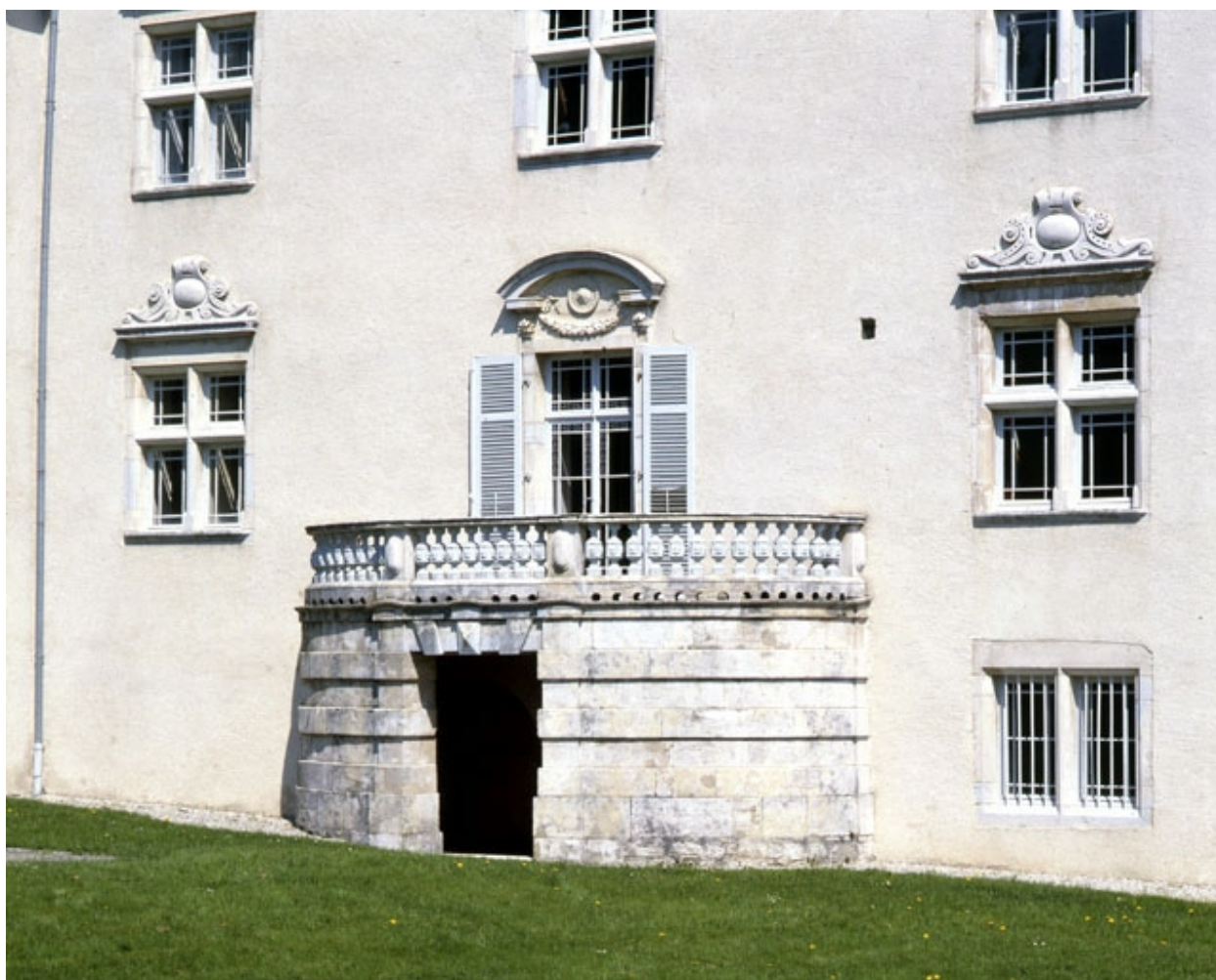
Détail : balcon façade postérieure.
