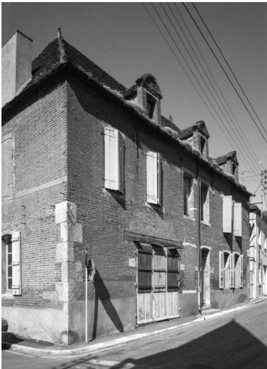
Vue d'ensemble d'une maison, 6 rue du Château.
