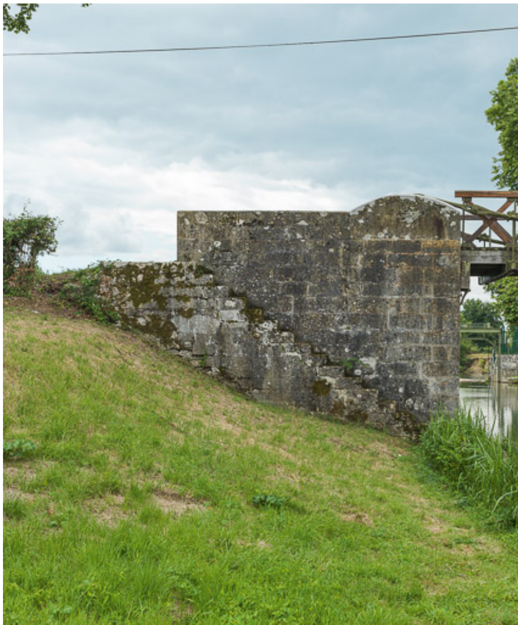
Détail d'une culée en moellons.
