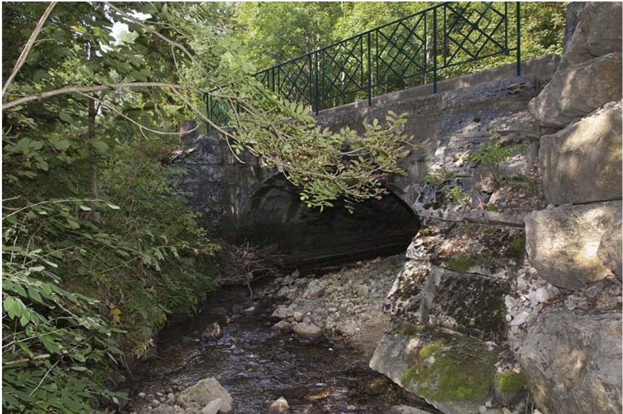
Pont sur la Jougne (n° 3), vu depuis l'aval.
