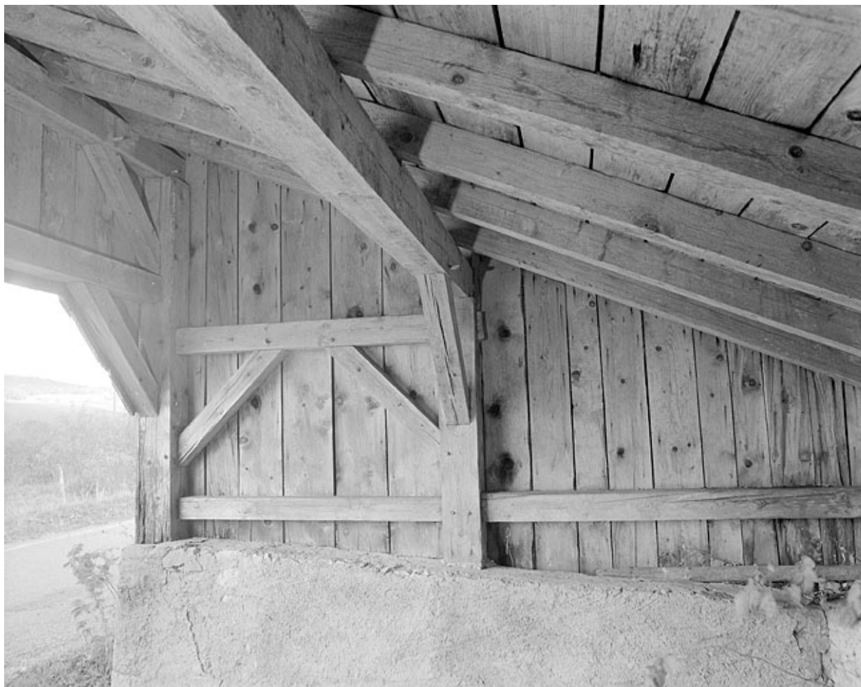
Détail de la charpente.
