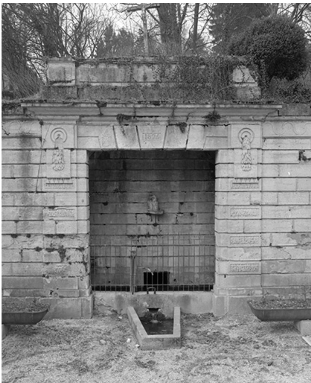
Vue de la partie centrale.
