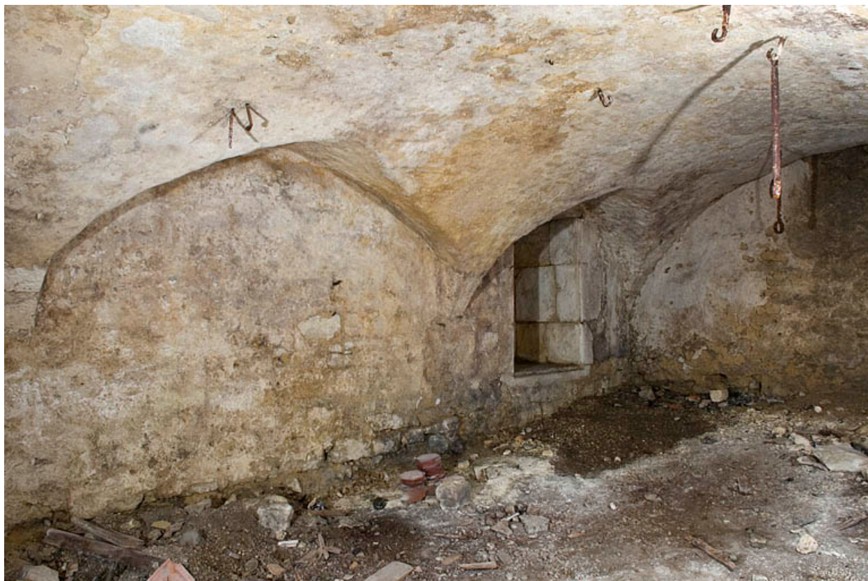
Sous-sol : vue de trois quart gauche.
