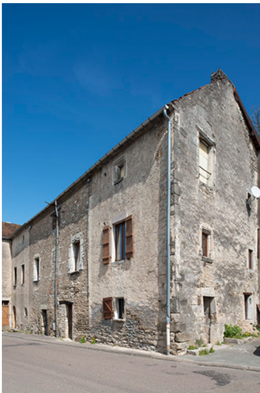
Vue de détail sur les ouvertures.
