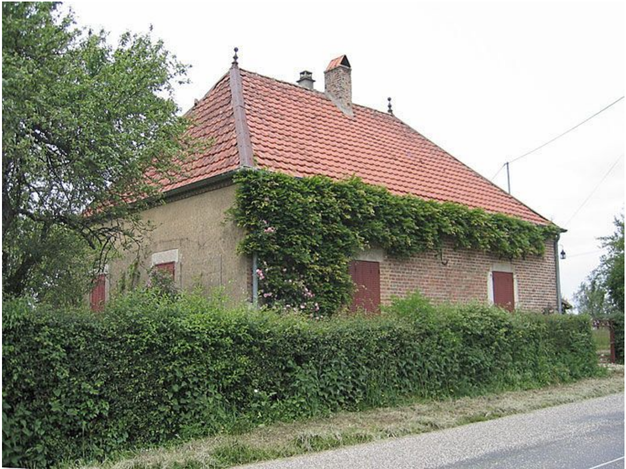
Vue d'ensemble de la façade de l'habitation.
