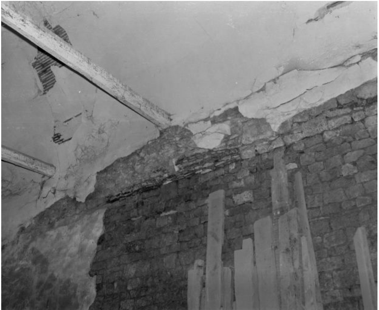
Mur gauche de la nef, détail.
