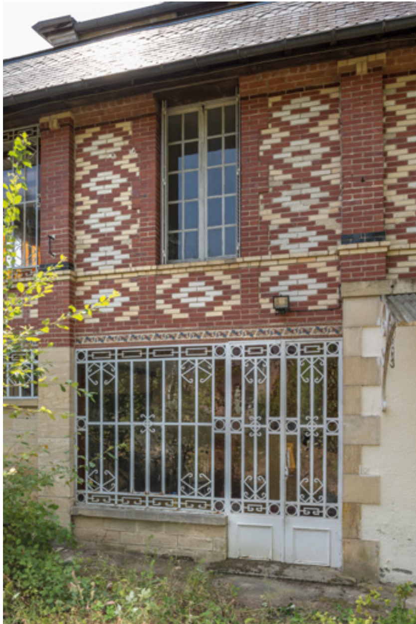
Élévation de l'extension en brique, côté nord.
