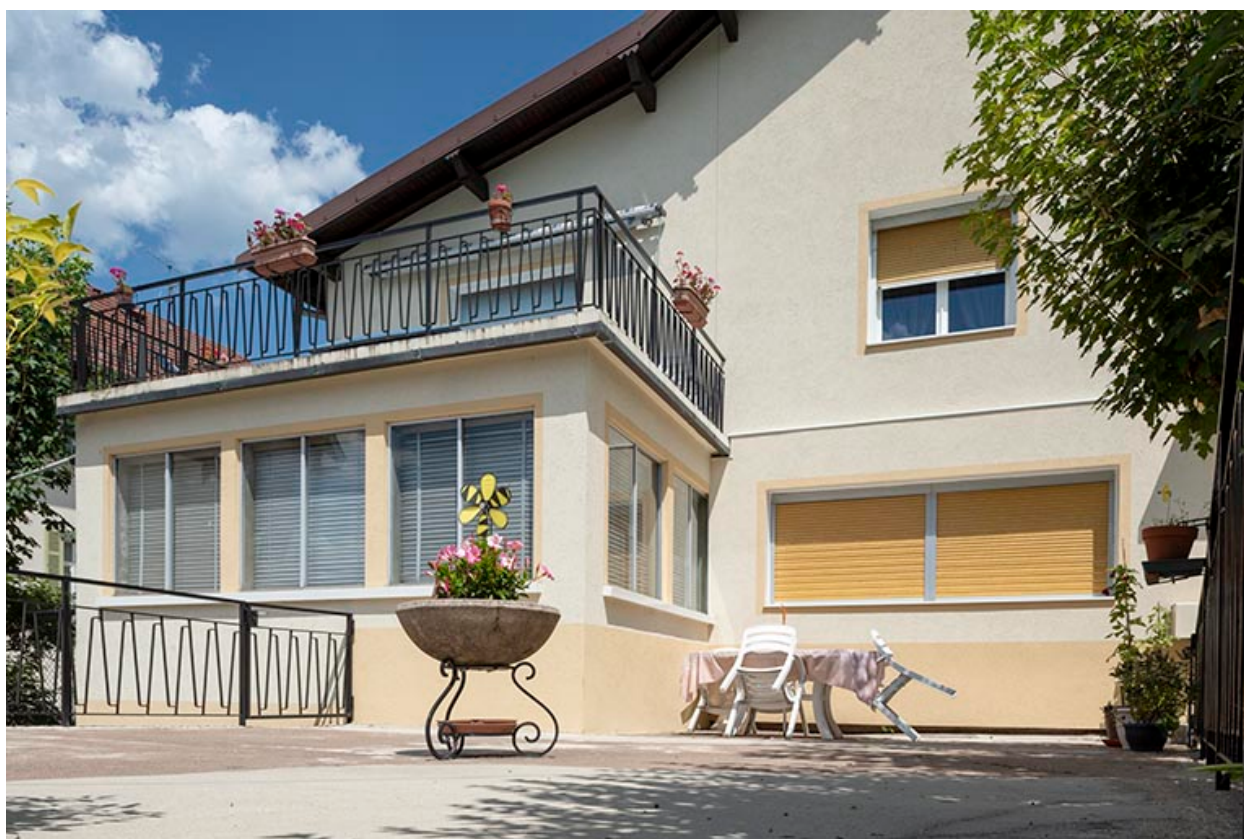
Maison et extension.
