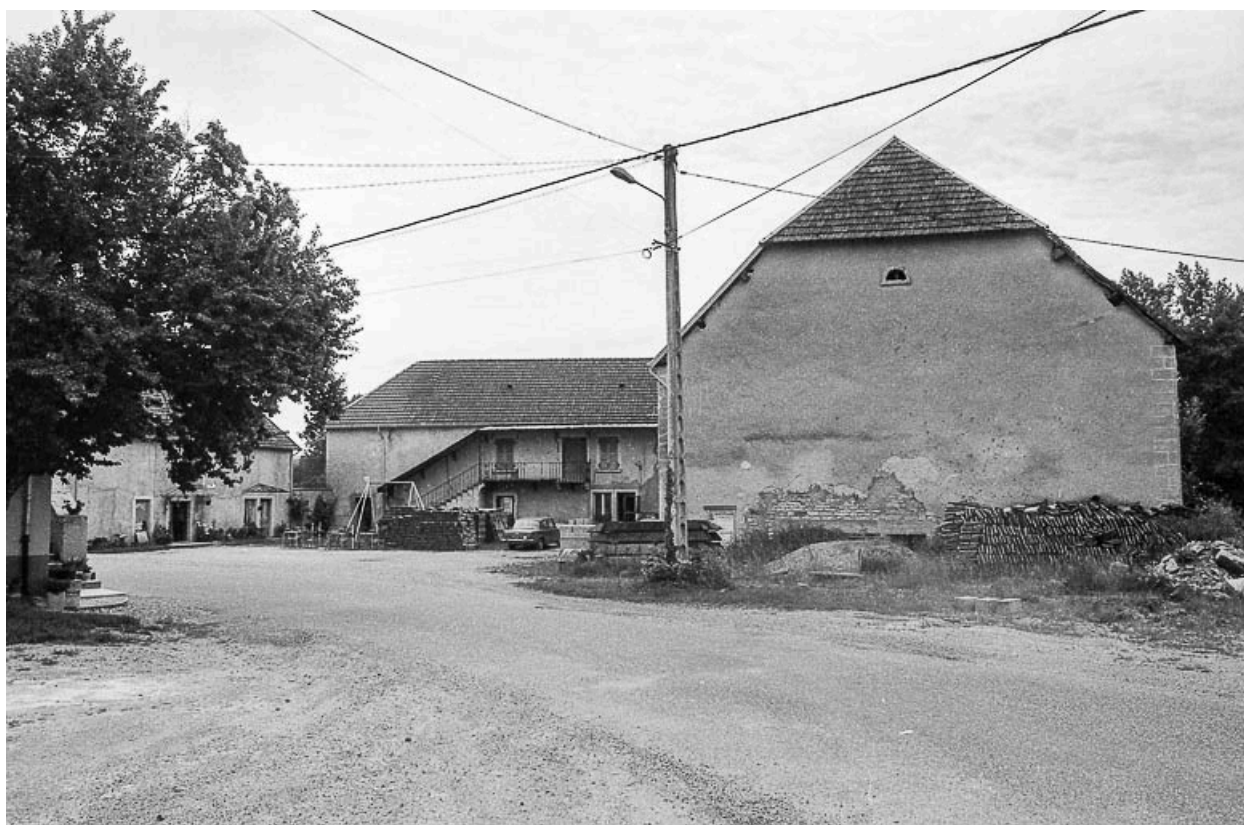
Vue d'ensemble des bâtiments en U.
