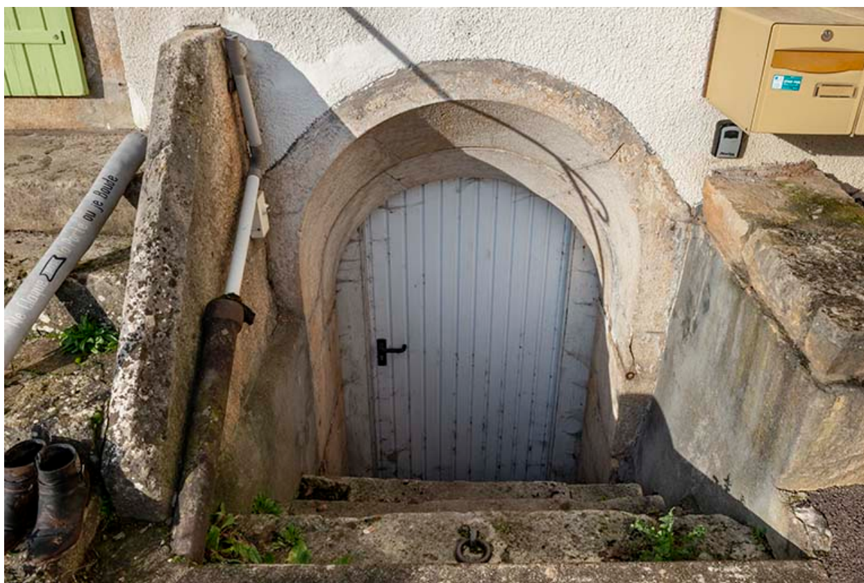
Escalier extérieur menant à la cave.
