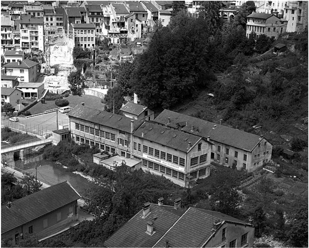
Vue d'ensemble plongeante depuis le sud-est.
