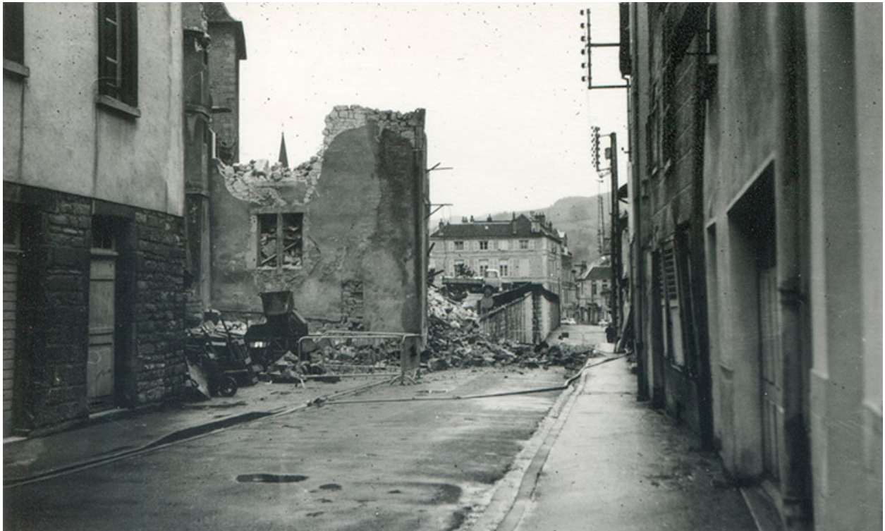
Démolition des bâtiments, vers 1973.
