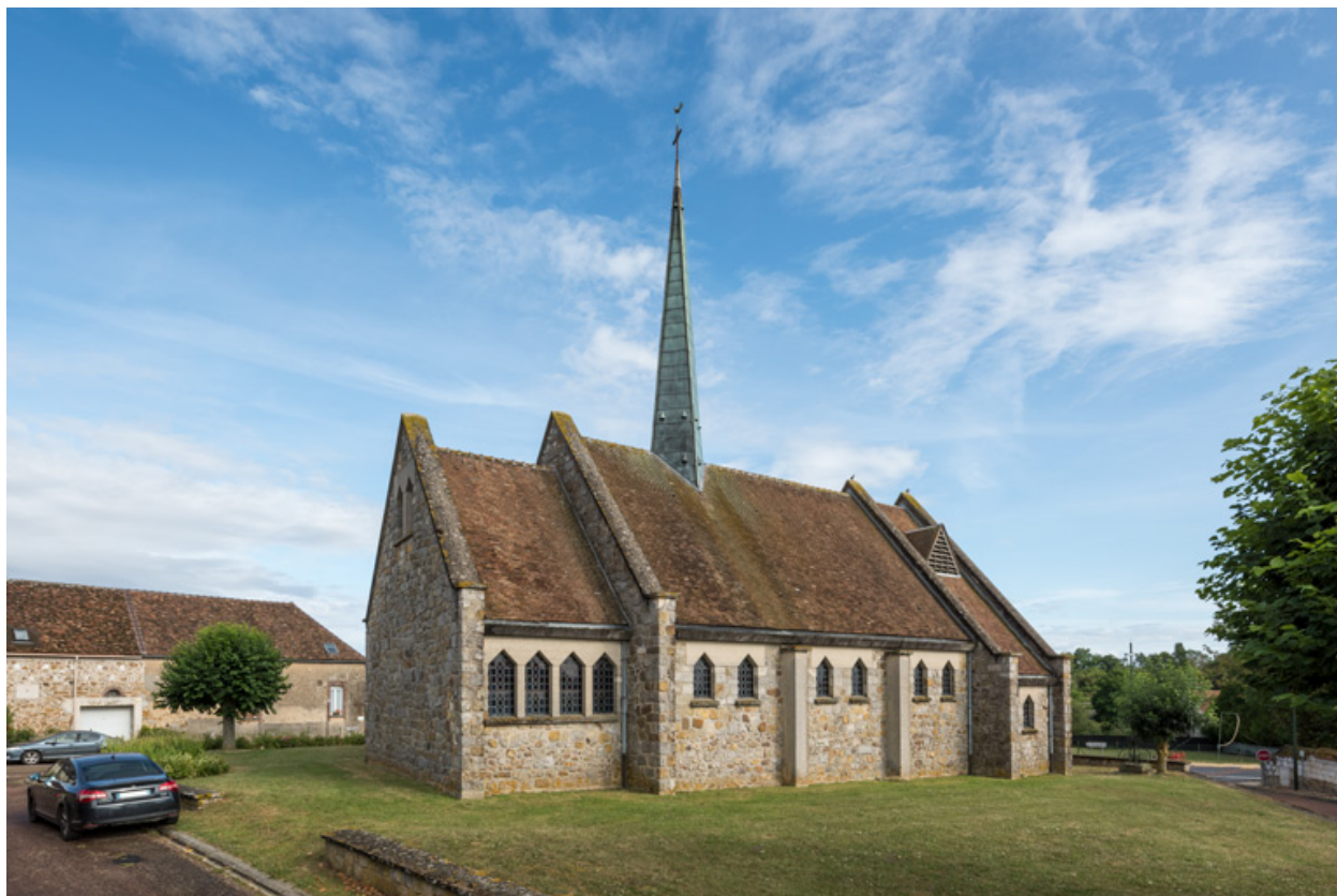
Elévations ouest, vue d'ensemble.
