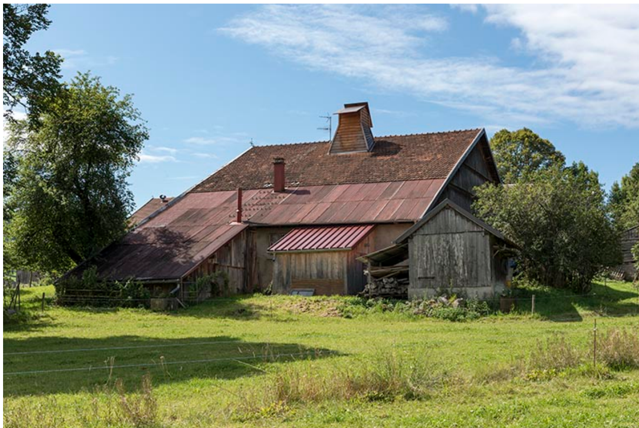
Façades latérale droite et postérieure.
