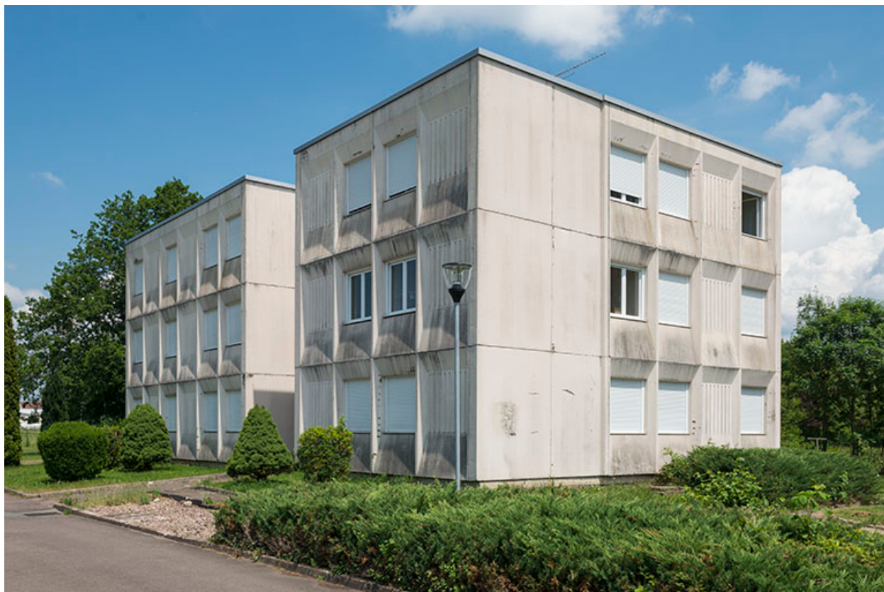
Angle sud-ouest des logements de fonction.
