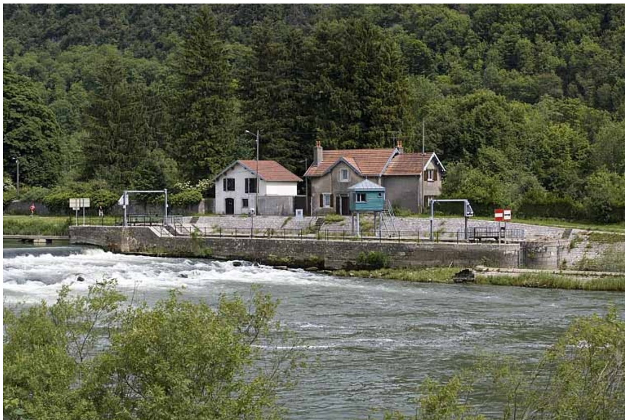
Vue d'ensemble rapprochée, depuis l'aval.
