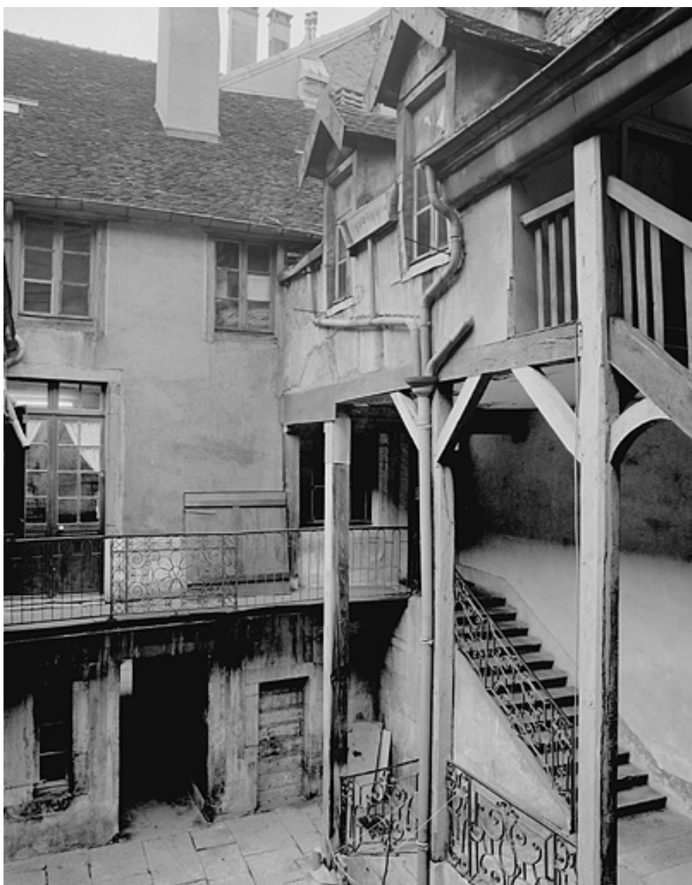
Vue de la cour intérieure avec l'escalier.
