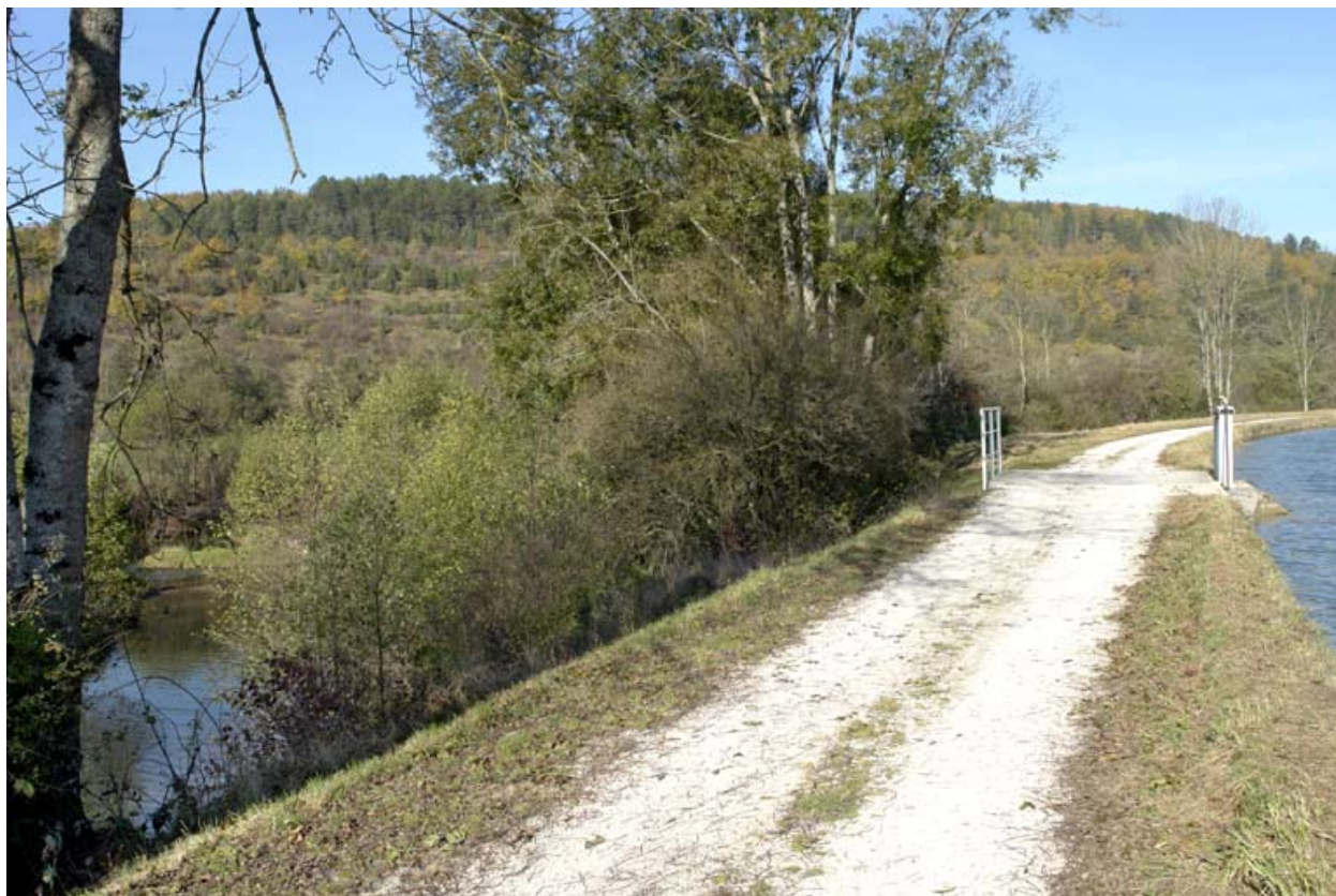
Le déversoir vu du chemin de halage.
